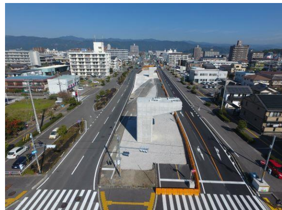
写真7 葛島第2高架橋下部工事
