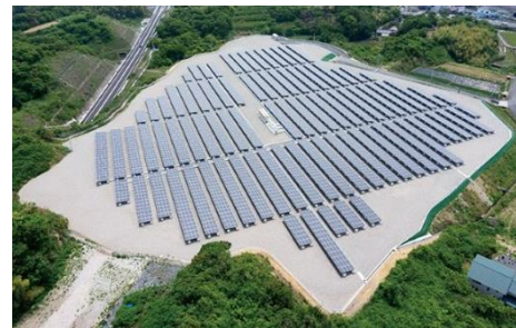
写真31 サンライトミタニ電力・発電所 (出典：ミタニ建設工業ウェブサイトより)
